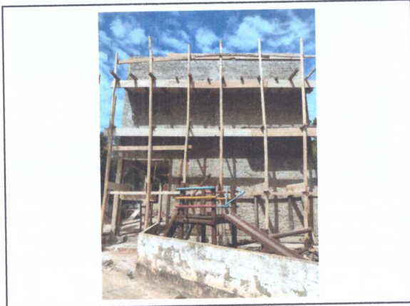
EXECUÇÃO DE CHAPISCO
