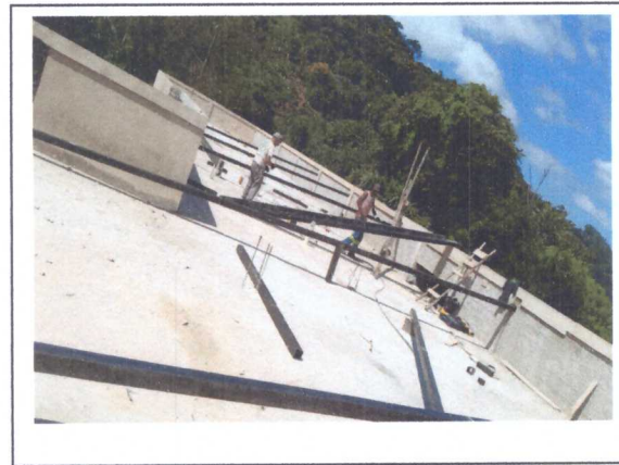
MOTANGEM DA ESTRUTURA DO TELHADO
