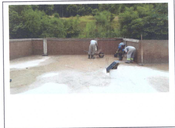
EXECUÇÃO DE EMBOÇO, (PLATIBANDA)
