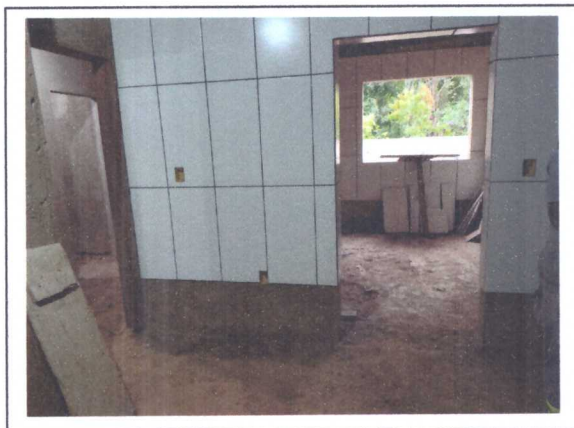
INSTALAÇÃO DE PONTOS DE TOMADAS
