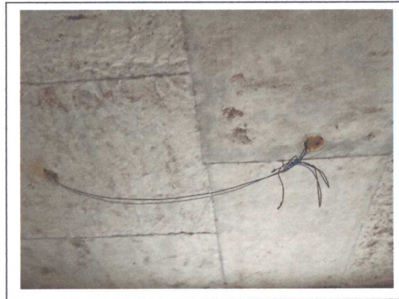
INSTALAÇÃO DE PONTOS DE LUZ
