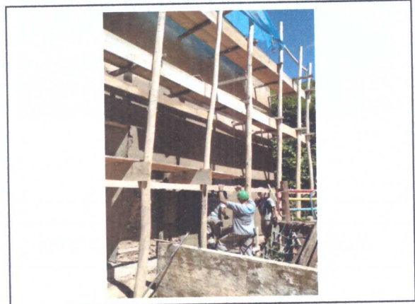
MONTAGEM DE ANDAIME
