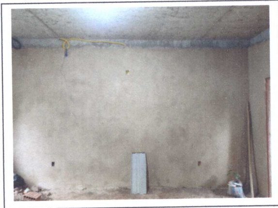
EXECUÇÃO DE REBOCO
