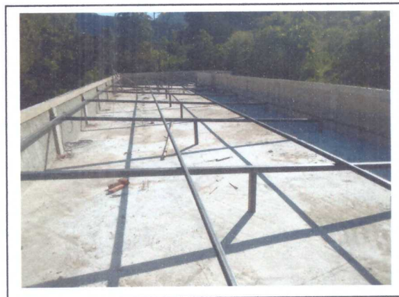
MOTANGEM DA ESTRUTURA DO TELHADO
