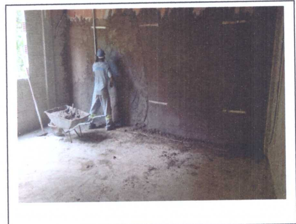
EXECUÇÃO DE EMBOÇO
