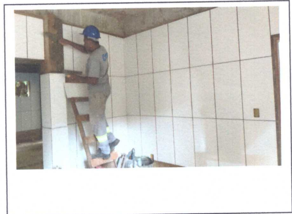
ASSENTAMENTO DE REVESTIMENTO
