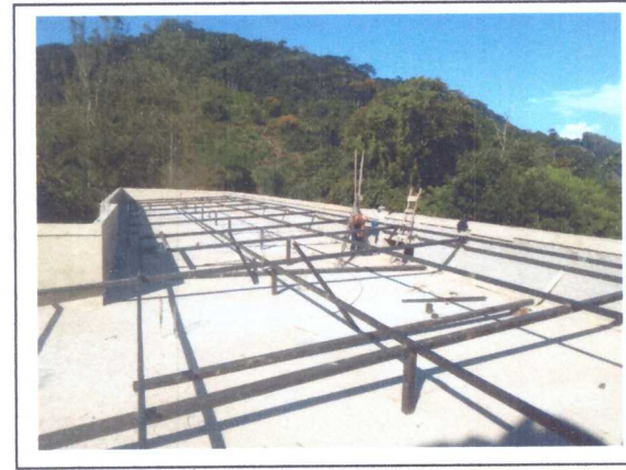
MOTANGEM DA ESTRUTURA DO TELHADO
