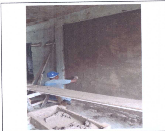
EXECUÇÃO DE EMBOÇO
