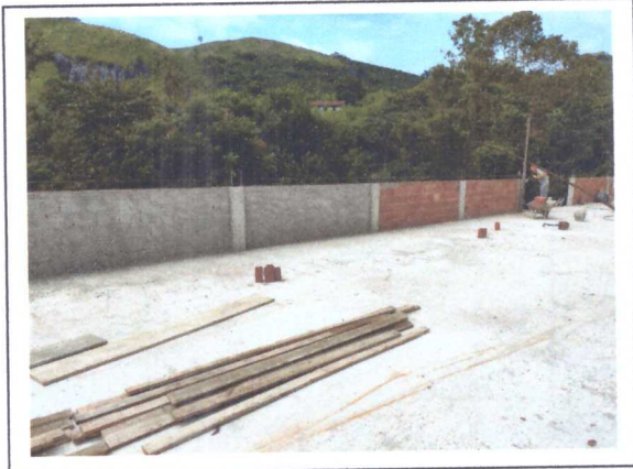
EXECUÇÃO DE CHAPISCO, (PLATIBANDA)
