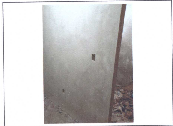
EXECUÇÃO DE REBOCO
