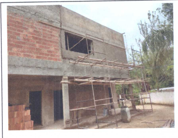
EXECUÇÃO DE EMBOÇO
